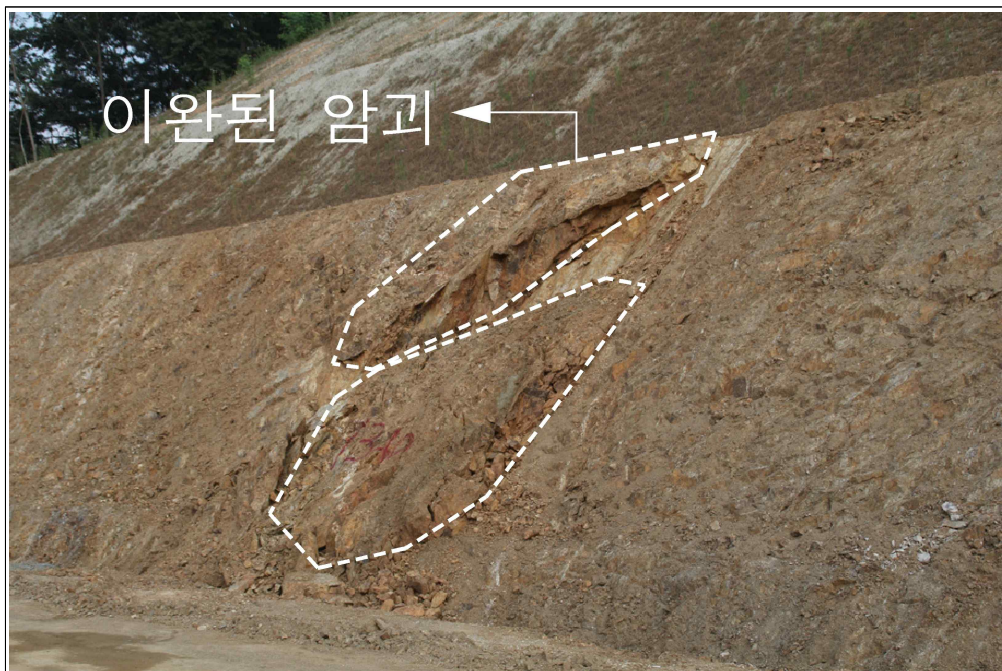
【그림 24】 B 영역 상세사진 (이완된 암괴)
