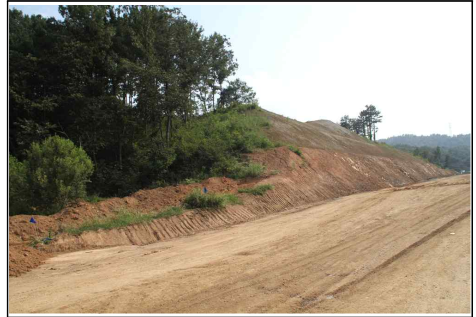
【그림 4】 깎기비탈면 종점부 측면 사진
