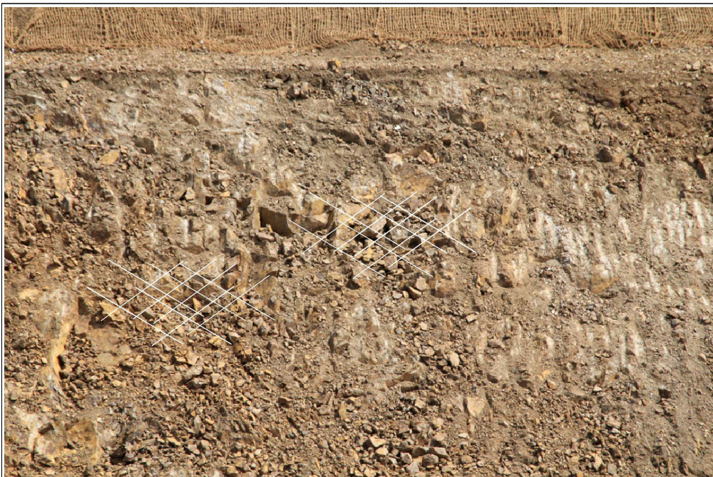
【그림 26】 B 영역 상세사진 (세편화된 암석)
