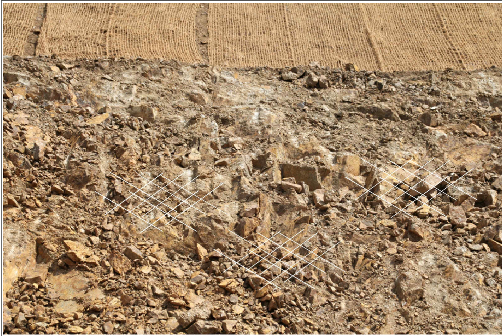
【그림 25】 B 영역 상세사진 (세편화된 암석)
